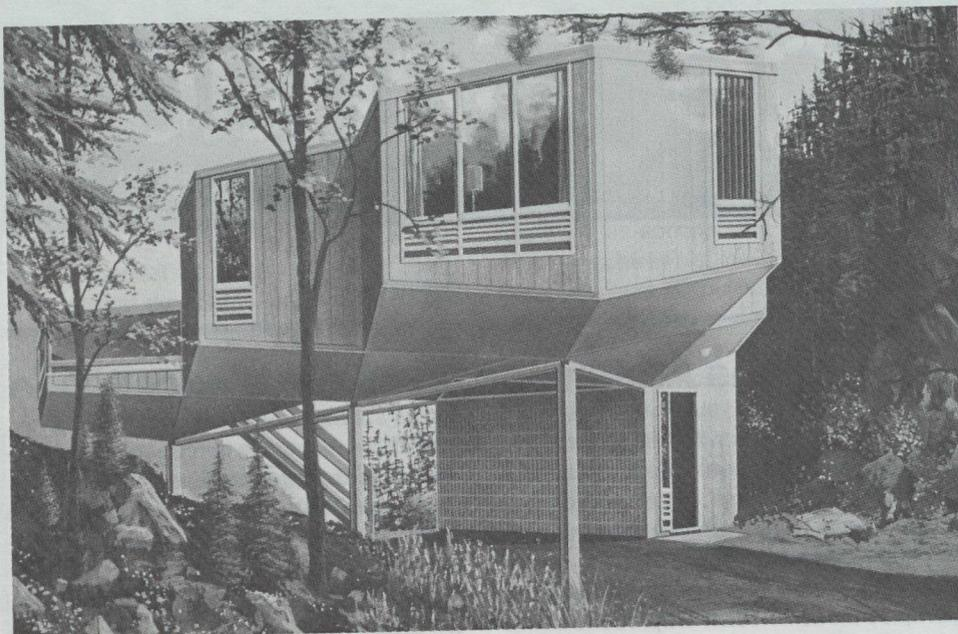
*L'architecture futuriste et la structure d'acier montée sur des piliers de béton font en sorte que le modèle Eureka ne passe pas inaperçu.*
