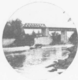
G. T. R. BRIDGE, KINGSTON MILLS.
