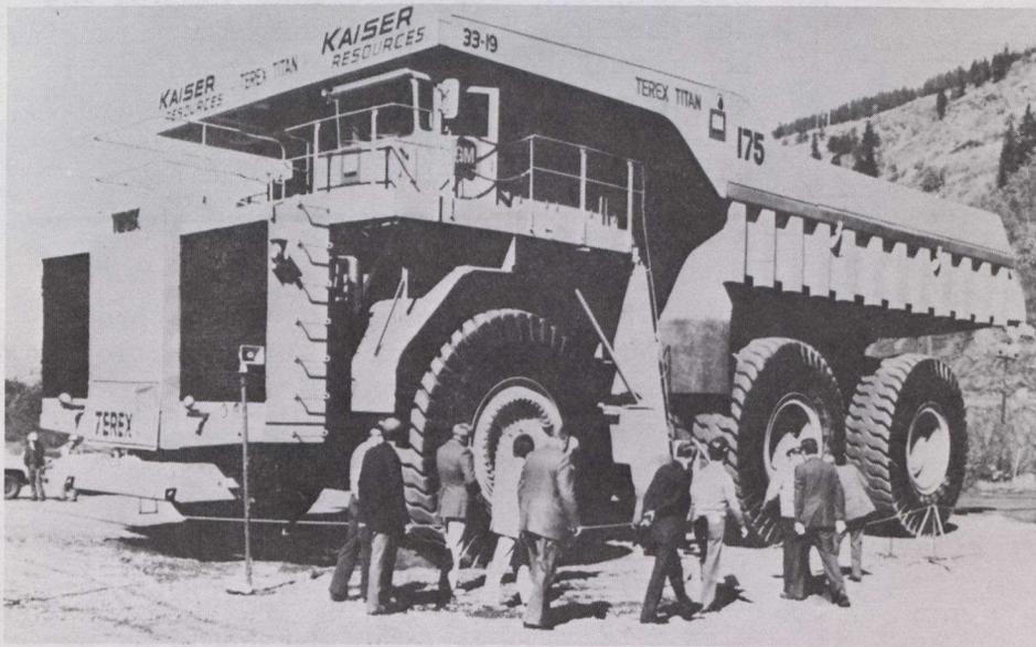
Considerado como el mayor camión del mundo, este vehículo de seis ruedas se utilizará en las operaciones extractivas de carbón de la Kaiser Resources Ltd. en el sureste de la Colombia Británica. El camión, fabricado en London, Ontario, y montado en la Colombia Británica, pesará 600 toneladas una vez cargado totalmente. Durante la operación de descarga tiene la altura de un edificio de seis pisos.
