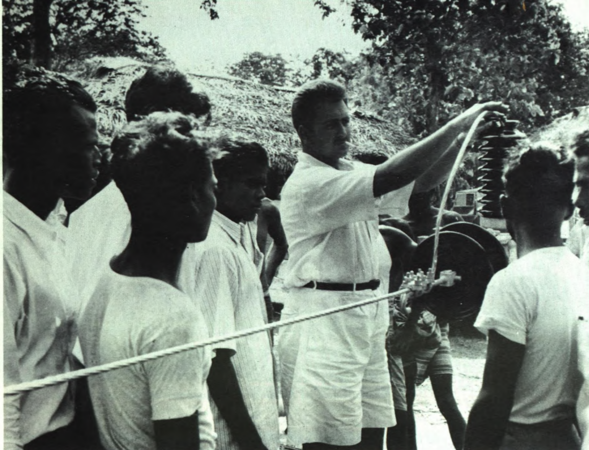
Ingénieur canadien des lignes de transmission d'énergie exposant à de jeunes Cingalais, dans la vallée de Gal Oya, les méthodes modernes de construction de lignes.
