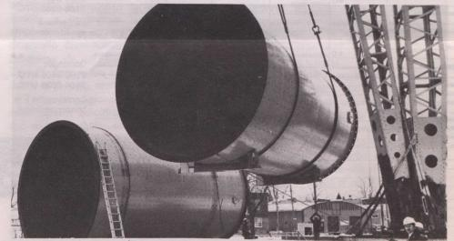
Estos enormes cilindros de trituración de mineral que aquí vemos en ruta hacia el puerto de Montreal son enviados a México como parte de un pedido de la compañía minera "Minera del Norte" a los talleres de ingeniería Dominion, de la Lachine. Los cuatro trituradores, fabricados por la Dominion, formarán parte de un complejo gigantesco de peletización, a punto de construirse por la empresa estatal siderúrgica Sidermex-México.
