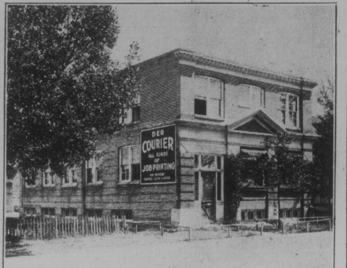
Das Couriergebäude (1835 Halifax Straße, Regina) mit Maschinenraum im Keller, Büroräumen und Buchbinderei im ersten Stock, mit Redaktion und Sekretariat im zweiten Stockwerk.
