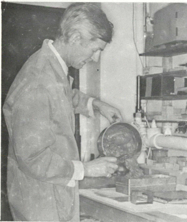
Gavin Macaulay place le mélange "fouetté" dans un moule métallique; c'est l'avant-dernière phase de la fabrication de la brique en mousse d'argile.
