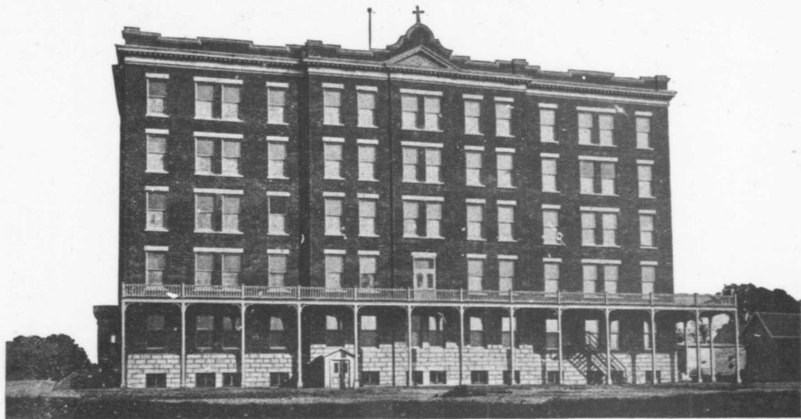
FAÇADE NORD DU NOVICIAT DES RELIGIEUX DU T. S. SACREMENT. QUÉBEC.
