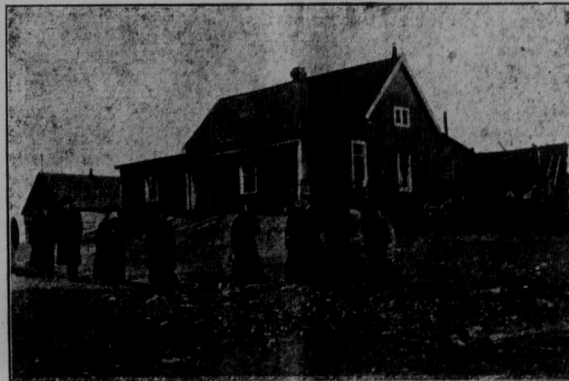
Das zweite Klostergebäude, erbaut in 1905.
