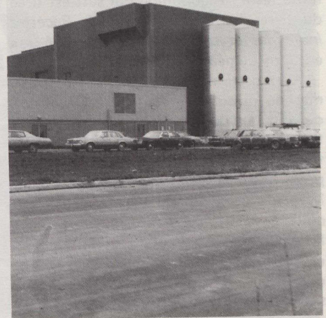
Vue partielle de l'usine de Sodispro.
