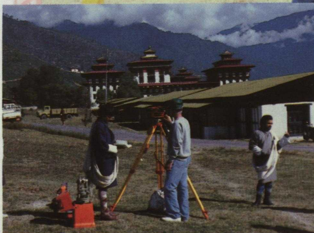
Terra exécute un levé de contrôle au Bhoutan.
