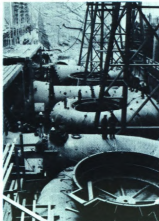
Centrale en cours de construction à l'aménagement de Warsak (Pakistan).
