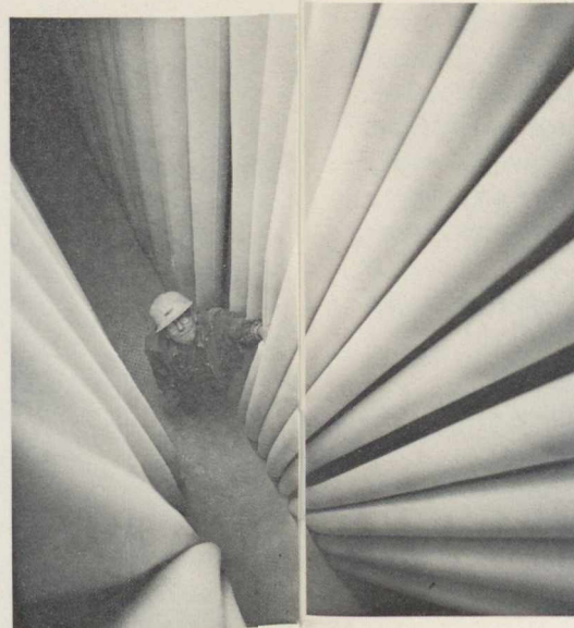
Le filtre géant de l'atelier de criblage d'un moulin dont la capacité est de 12 000 tonnes de minerai par jour.
