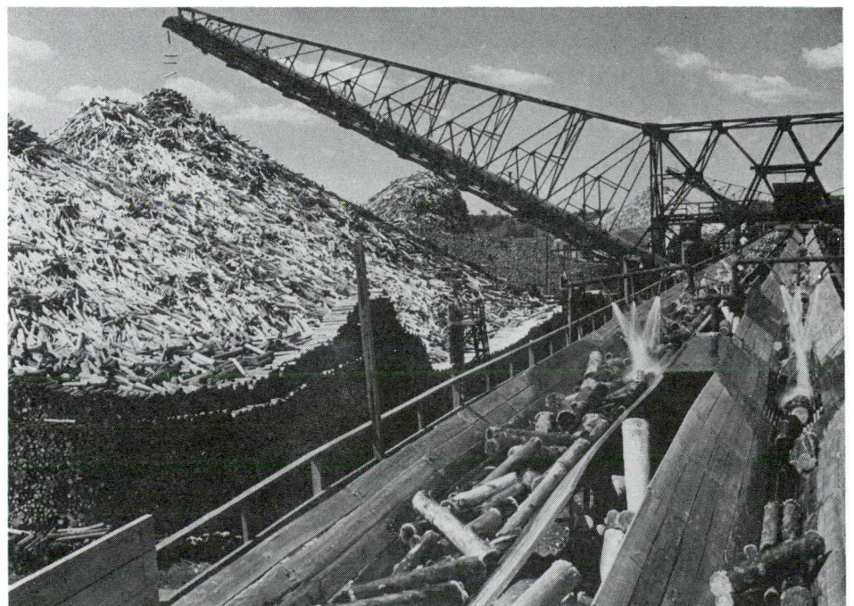
Mise en tas au moyen d'un convoyeur, à Fort William, Ont.
