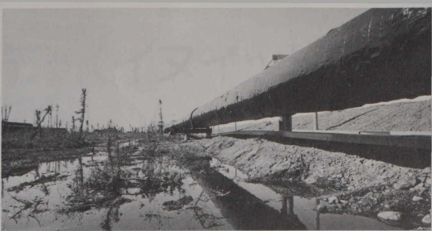
北方から石油を運ぶパイプライン。 経済的・社会的影響が大きく論議された。
