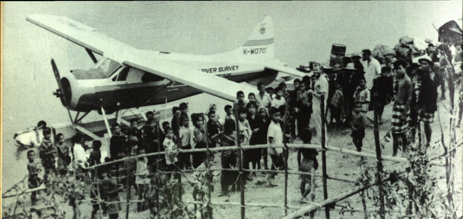
Aménagement du Mékong. Avion canadien servant aux relevés.
