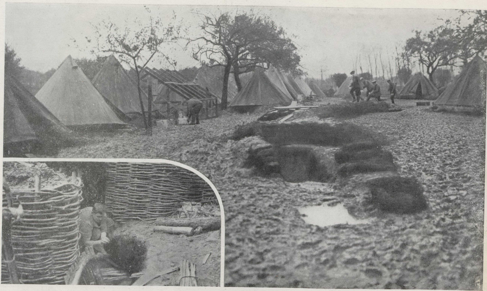
L'ARMÉE ANGLAISE EN BELGIQUE Camp Anglais en Belgique montrant la construction des tranchées.
