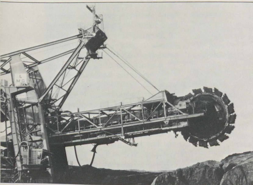
La pelle excavatrice à godets. Diamètre de la roue: dix mètres.
