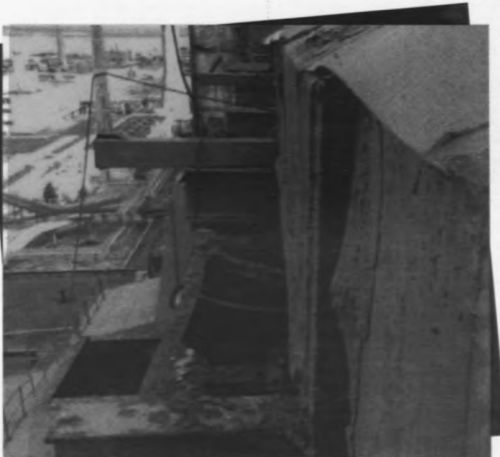
Vue de proche d'une partie du Sarcophage construit par les Soviets autour de l'unité 4 de Tchernobyl.
