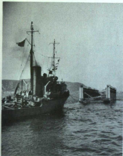
Bassin de radoub flottant remorqué vers St. John's. Septembre 1943.
