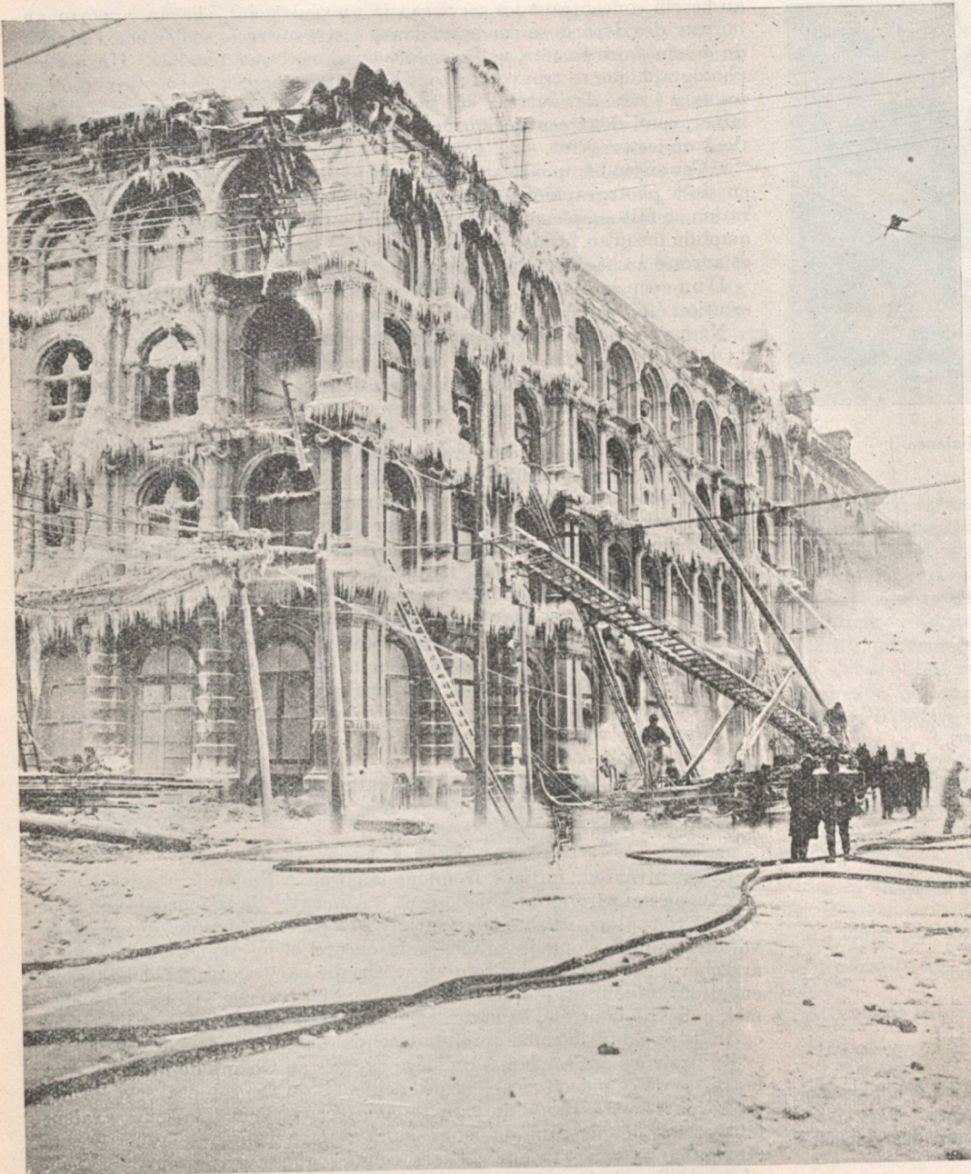
L'ÉDIFICE DE THOMAS MAY &amp; CO. APRÈS LA CONFLAGRATION.
