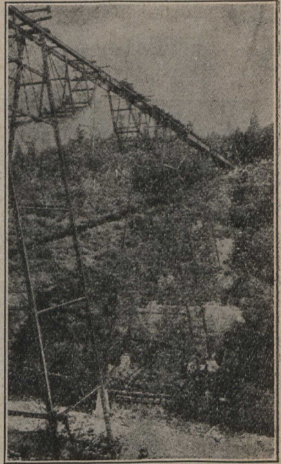
Le plus haut pont de la Californie.
