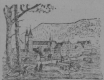
Hirfau vor der Zerstörung.
