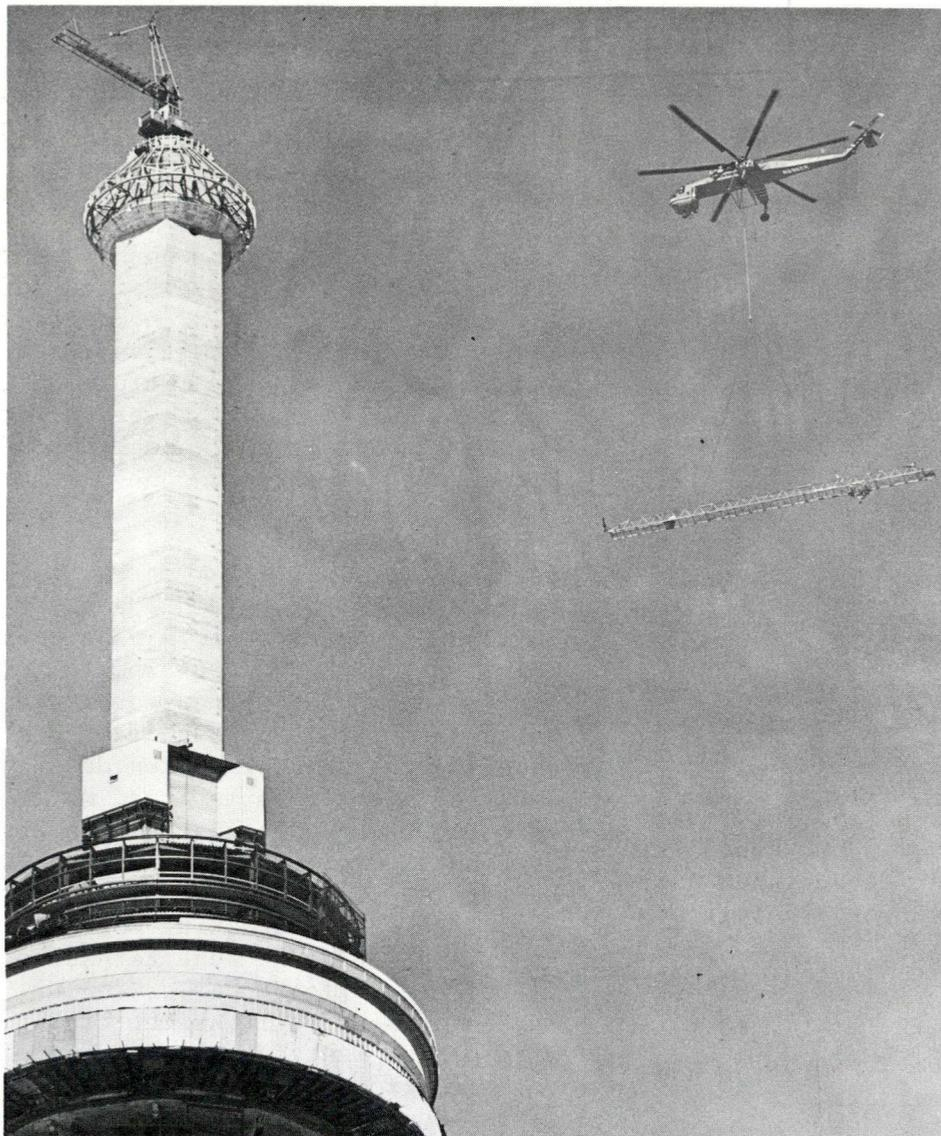
*Der Skycrane-Hubschrauber setzt einen der 39 Teile des Sendemastes auf den CN-Turm in Toronto, der heute das höchste freistehende Bauwerk der Welt ist*
