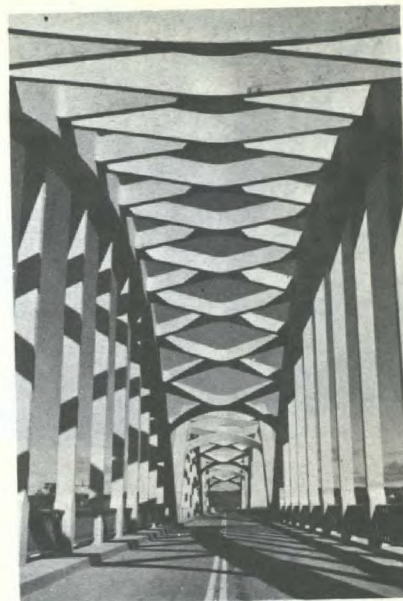
Pont en ciment sur une rivière de la Saskatchewan
