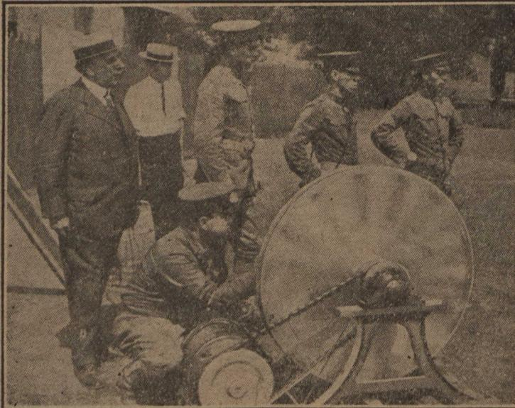
canon, nouveau modèle. Il consiste en une grande roue en aluminium et en cuivre, laquelle tourne sur une roue dentelée, le tout étant supporté par une charpente de fer.
