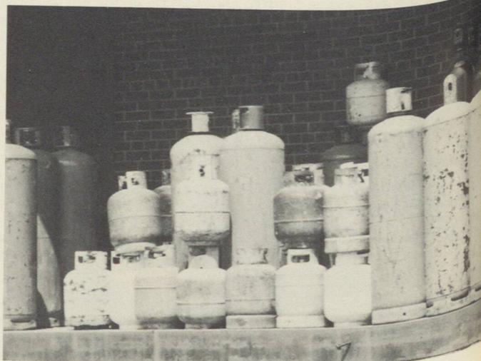
Conventional hydrogen storage containers such as these may some day be replaced by less heavy storage vessels, using metal hydrides as a "sponge" for the gas. • Il se peut que ces lourds réservoirs soient un jour remplacés par d'autres plus légers et utilisant des hydrures métalliques.
