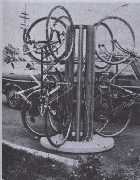
On peut installer le support monté sur socle dans une place de stationnement. Il peut supporter jusqu'à dix bicyclettes.
