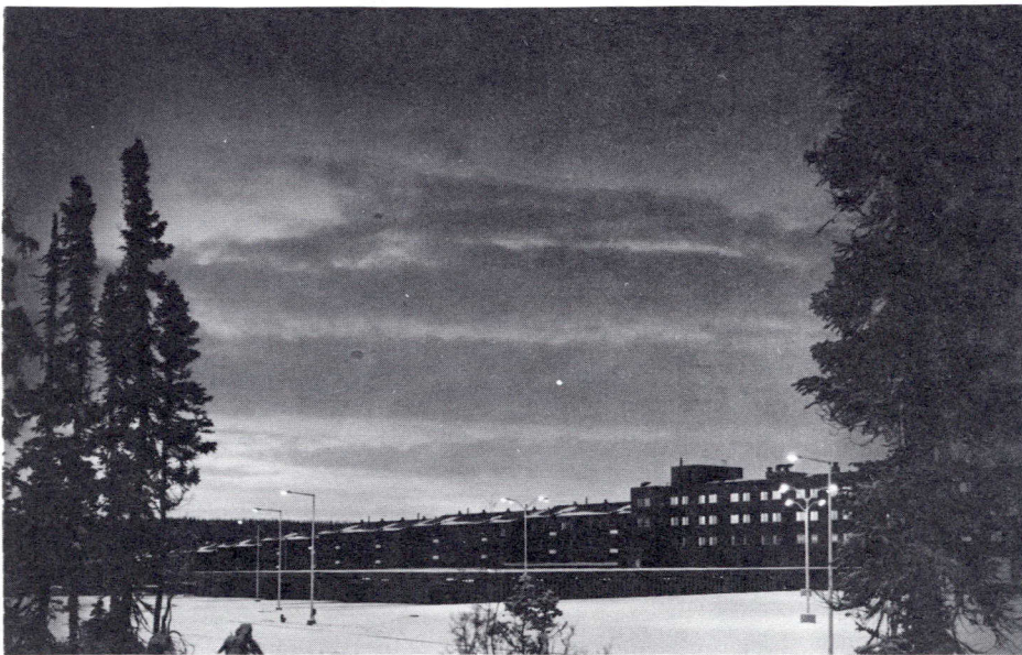
Ein Teil von "The Windshield". Das ganze Gebäude ist knapp 1,6 km lang
