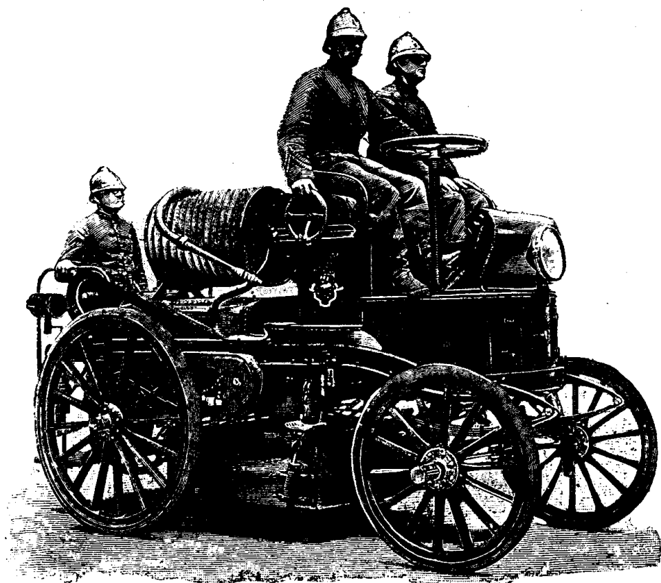
PARIS. — LA POMPE ÉLECTRIQUE EN MARCHÉ
