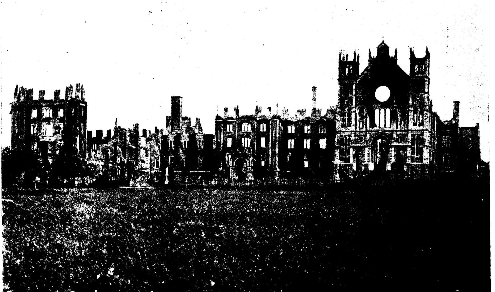
VILLA-MARIA — VUE GÉNÉRALE DE L'ÉDIFICE EN RUINE, PRISE DU COTÉ DE L'EST Photographie Laprés—Photogravure Armstrong
