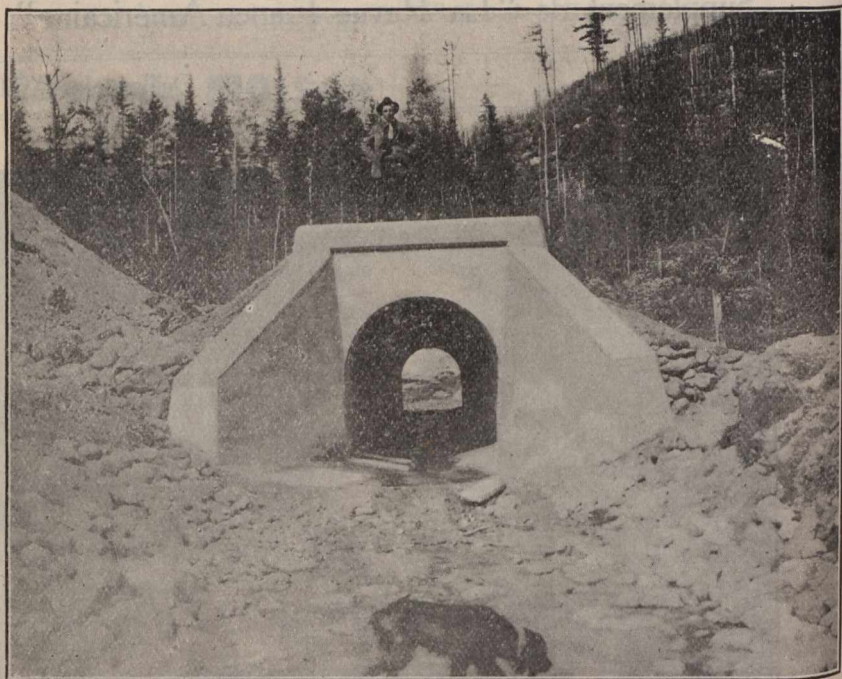
Le Transcontinental Canadien.—Section de Québec.—Ponceau en béton près de La Tuque.
