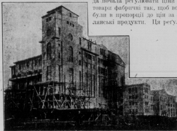
Нова велика електрична Штерівська станція в Донбасі; на Україні, збудована й відкрита минулого літа.
