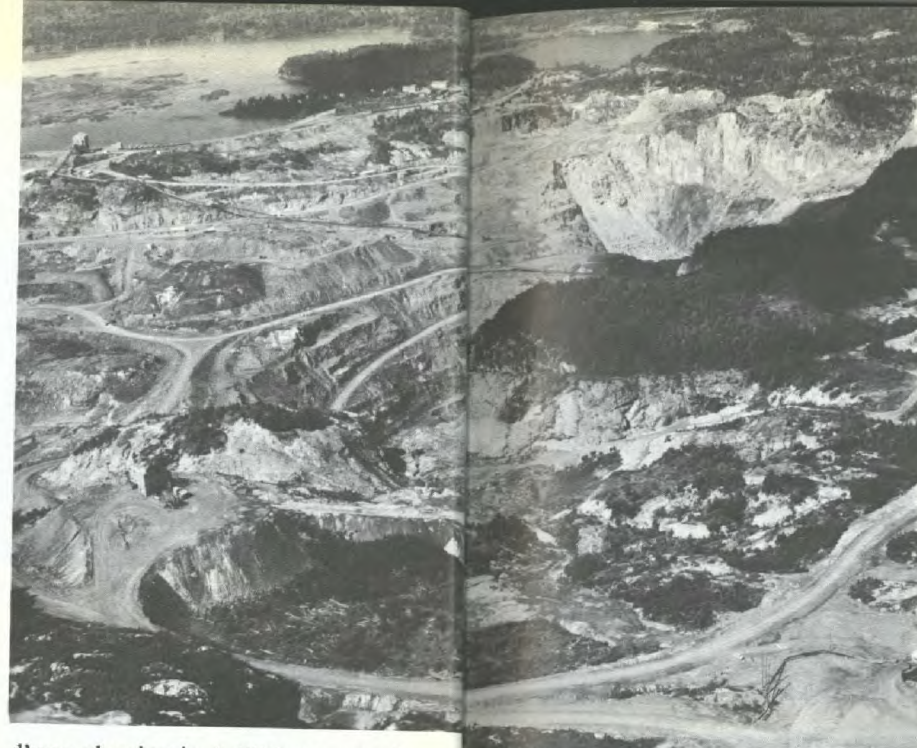
Mines de fer de Steep-Rock. Cette exploitation a nécessité l'assèchement d'un lac de 15 milles de longueur et le perçage d'un tunnel de 2,000 pieds dans le roc solide
