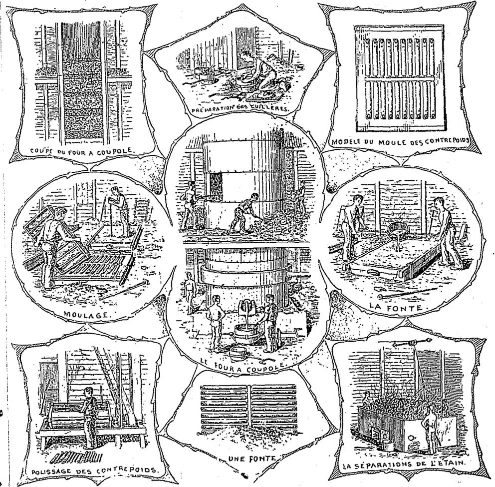
L'utilisation des vieilles boîtes de conserves à la fabrication des contre-poids pour fenêtres à guillotine
