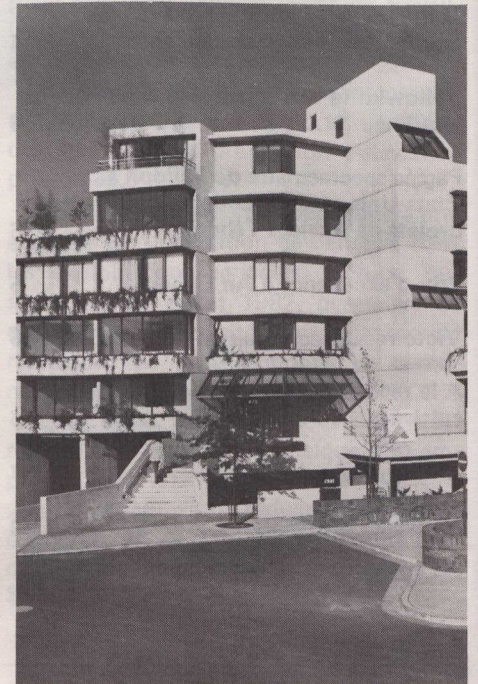
Appartements de luxe dans le lotissement.
