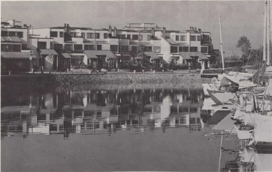
Les maisons de rangée sont à proximité du port de plaisance de False Creek.
