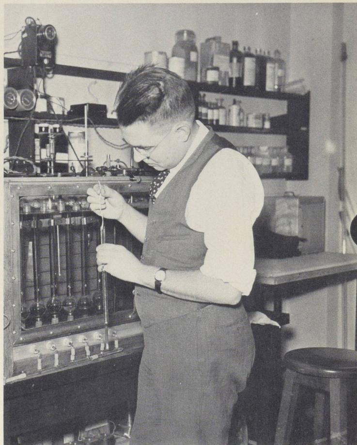
Mr. Bayley preparing to run a cuprammonium fluidity test — in the 1930s. A fluidity test is used to determine whether cellulose has been chemically damaged. • M. Bayley s'apprêtant à procéder à un essai de fluidité au cuivre ammoniacal, au cours des années trente. Cet essai permet de déterminer si la cellulose a été endommagée par action chimique.
