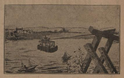
Vous avez vu, peut-être, dans certaines exploitations minières, des chariots accrochés par une poulie à des fils métalliques tendus à travers l'espace. Ce système est fort usité pour faire franchir aux bennes de larges excavations. Le fil métallique est double, ce qui établit un va-et-vient dans chaque direction opposée, le chariot plein qui descend faisant remonter au moyen d'un câble un chariot vide.
