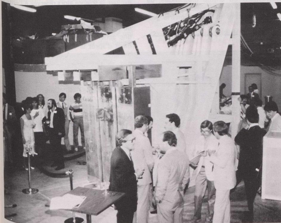
Actionnées vers l'avant, les trois poutres métalliques du batteur à houle créent des vagues qui peuvent simuler, à échelle réduite, une tempête en mer et aider les ingénieurs à concevoir des bateaux ou des quais plus solides.
