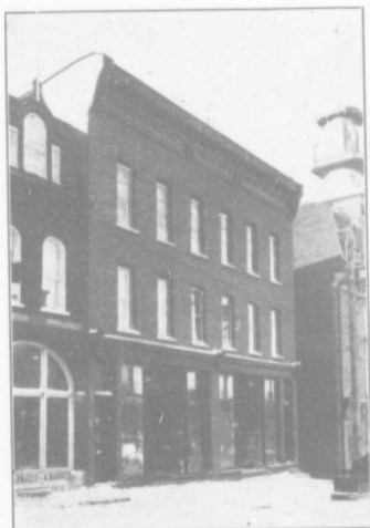
Residence of F. PICHETTE 62 Cote du Passage
