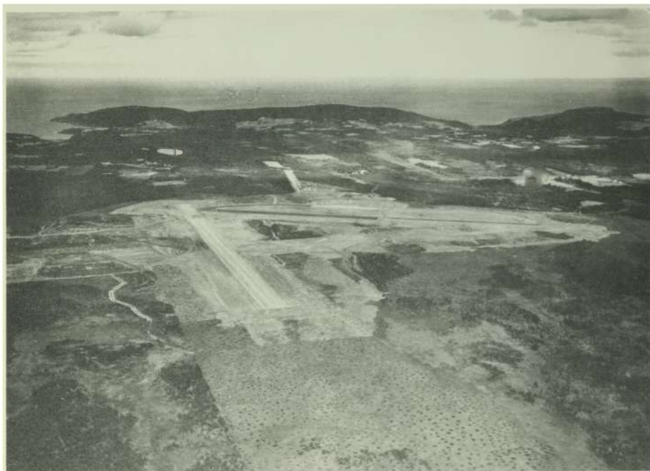
Construction de l'aéroport de Torbay. Octobre 1941.
