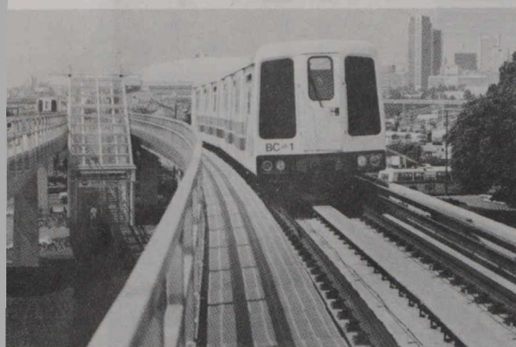
エキスポ86の会場となるバンクーバーで建設中のリニアモーターカー。
