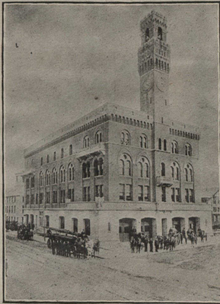
Le poste central des pompiers.
