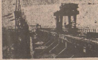
發開期一第游上河黃是站電水峽銅青 站電水峽銅青 共台八的站電個道，底年去去。一之程工紐福利水級梯的 電水為圖。畢完裝安部全已組機電發輪水瓦千二。景外站
