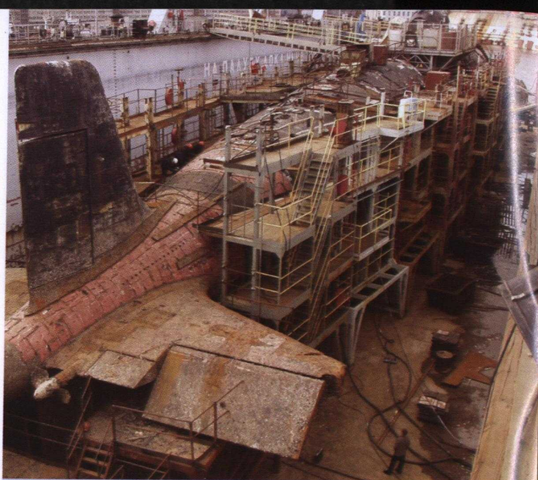
Sous-marin de la classe « Victor I » démantelé dans un dock flottant
