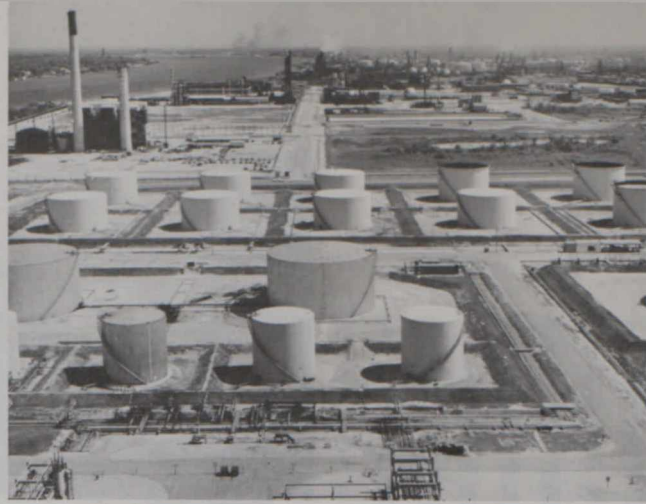
アルバータ州の 石油精製工場群。
