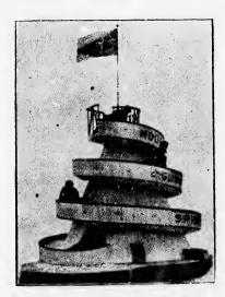
Le nombre des circuits autour du modèle est, à cause du peu de hauteur, limité à trois, afin de donner au glisseur la hauteur nécessaire à son évolution; réduisant aiusi à quelques 85 pieds la longueur totale ou développée du parcours de la glissade; mais si ou construisait la glissoire, par exemple, avec une hauteur
