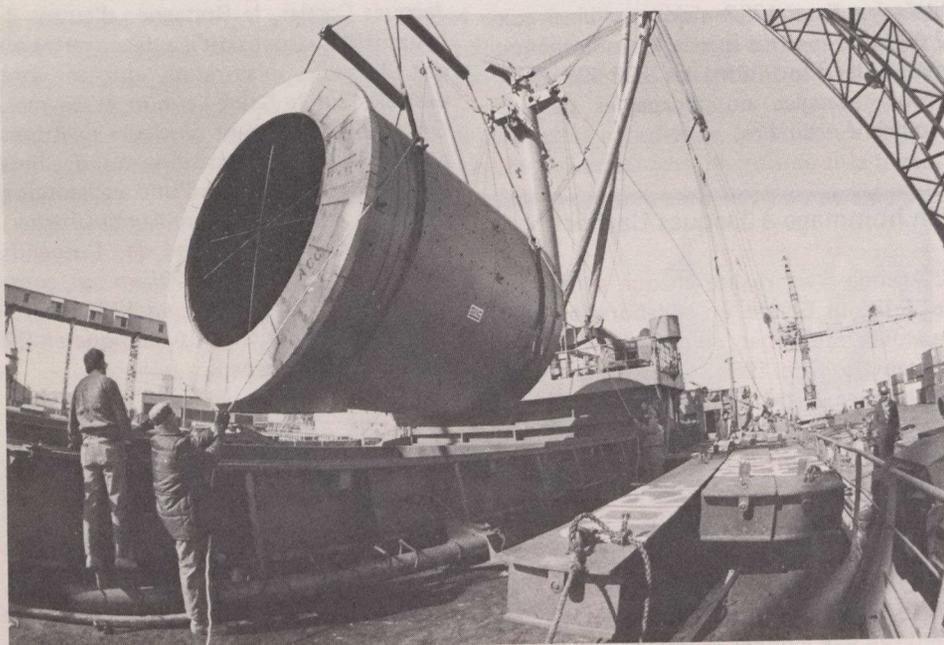
Une bigue du port de Montréal charge un bâti de broyeur à boulets de fabrication canadienne à bord du Heidi Leonhardt, affrété au Canada et en partance pour le Pérou. Le broyeur à boulets fait partie d'un chargement de plus de 10 000 tonnes de biens d'équipement fabriqués au Canada et achetés par le Groupe SNC pour le concentrateur de cuivre de Tintaya.
