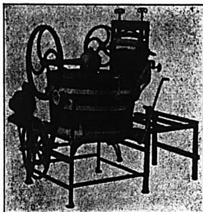
Maxwell est manoeuvrée par un moteur de huit chevaux-vapeur qui peut se visser à toute commutation ordinaire. La tordeuse peut se déplacer comme on le désire. Toujours sous un parfait contrôle. Peut être mise en marche par moteur à gazoline, si on le veut. Lave les tissus les plus délicats sans aucun danger pour eux.
