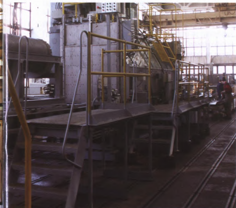
Chaîne de destruction d'armes chimiques pour le deuxième bâtiment, à l'usine de destruction de Shchuch'ye
